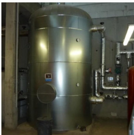
Abb. 40: Pufferspeicher
