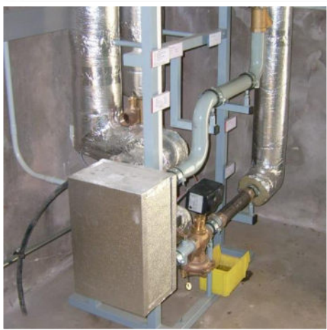
Abb. 42: Wärmeübergabestation
