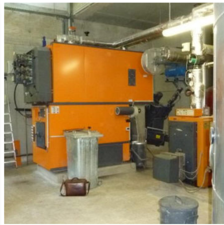
Abb. 39: Holz-Hackschnitzelkessel
